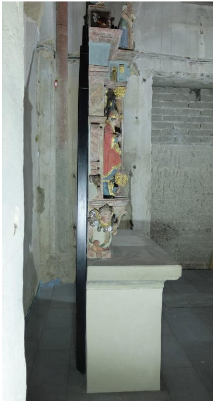
Abb. 11-13: Beispiel für den Aufbau eines freistehenden Altares mit einer rückseitigen stählernen Tragwerk- konstruktion (Aufnahme Thomas Lutgen, 19. Dezember 2017).
